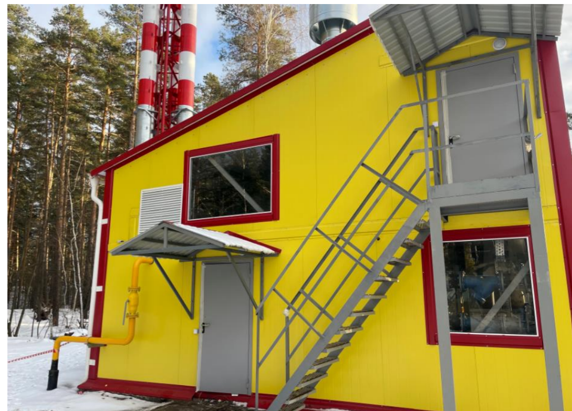
Блочно-модульная котельная, мощностью 4,3 МВт
